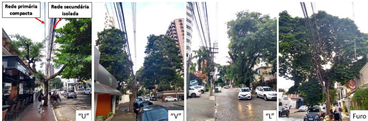
Figura 6. Rede primária compacta e secundária isolada em diferentes tipos de poda
