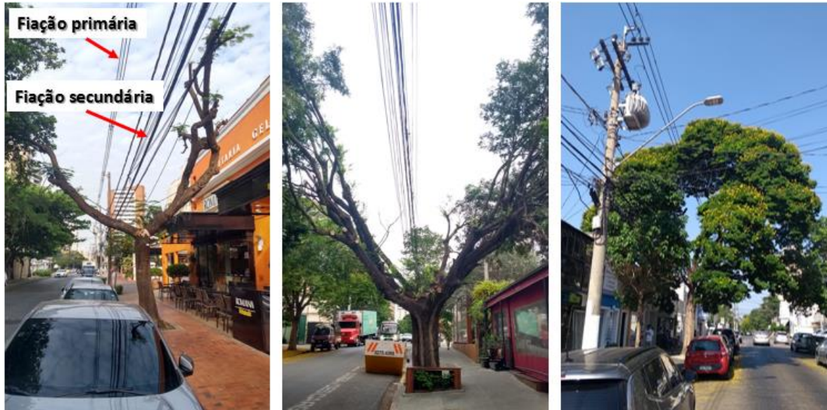
Figura 8. Localização das redes primária compacta e secundária isolada em diferentes tipos de poda. Respectivamente, “U”, “V” e furo, sendo apenas esta última a adequada Figure 8. Location of compact primary and isolated secondary networks in different types of pruning. Respectively, “U”, “V” and hole, only the latter being the appropriate
